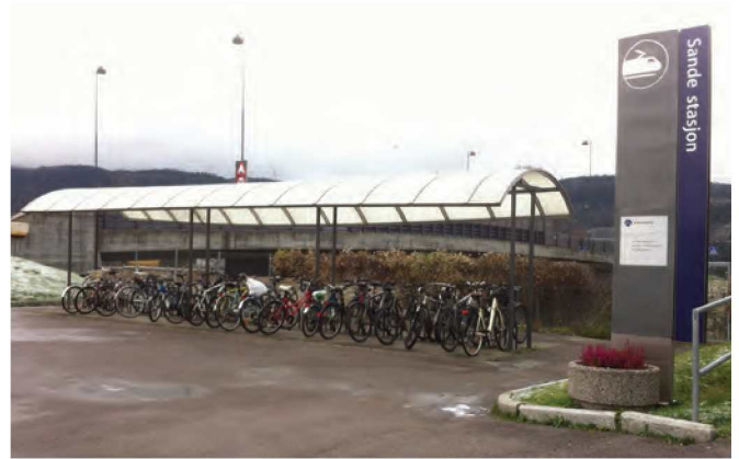
Sykkelparkering under tak. Sande stasjon.
