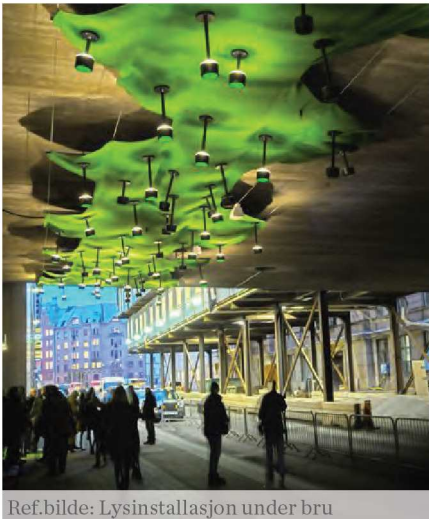
Ref.bilde: Lysinstallasjon under bru
