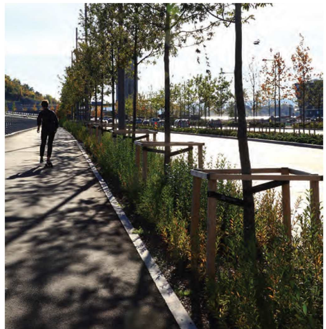
Eksempel på gang- og sykkelveg som er adskilt fra kjørebane med et frodig plantefelt. Kong Håkon 5.s gate i Oslo. Gaten har også nisjer med benker i vegetasjonsfeltet.
