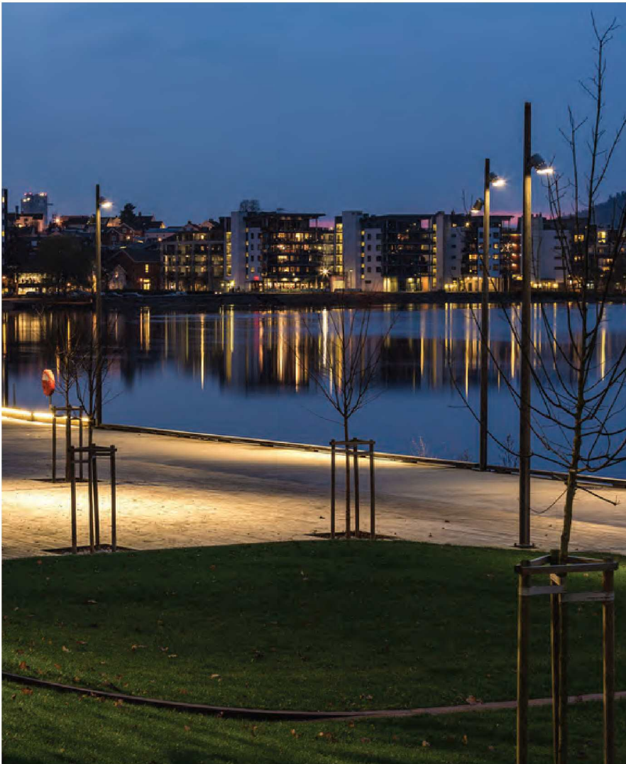
Referansebilde: Lav mast med avskjernet armatur
