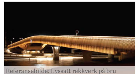
Referansebilde: Lys i rekkverk
