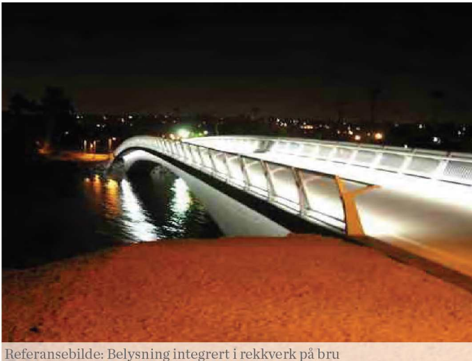
Referansebilde: Belysning integrert i rekkverk på bru
