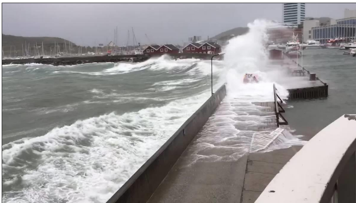
Figur 7: Eksempel på overskylling i Bodø under stormen Sally i 2020 (bølgetilstand H_s=1.4 \text{ m} / T_p = 4.5 \text{ s} ). Molo ligger på kote +3 \text{ m} (NN2000). Vannstand var 1.9 \text{ m} . Gjennomsnittlig overskylling er estimert til 5 \text{ l/m/s} basert på EurOtop (2018).
