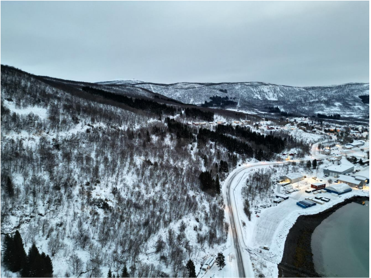
Bilde 3: Oversiktsbilde av nedre deler av påvirkningsområdet sett mot sørøst.
