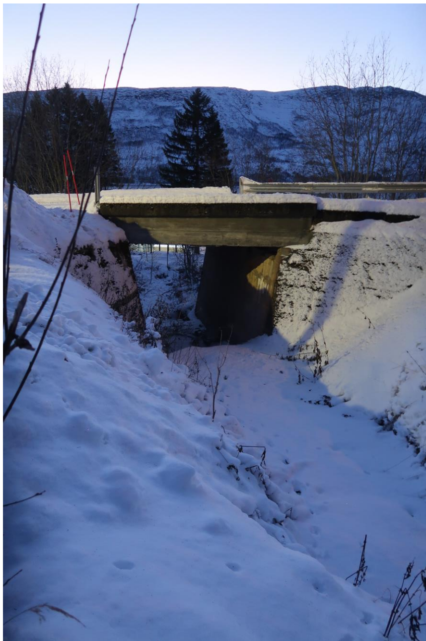
Bilde 8: Kulvert som leder bekkeløpet under fylkesveien.
