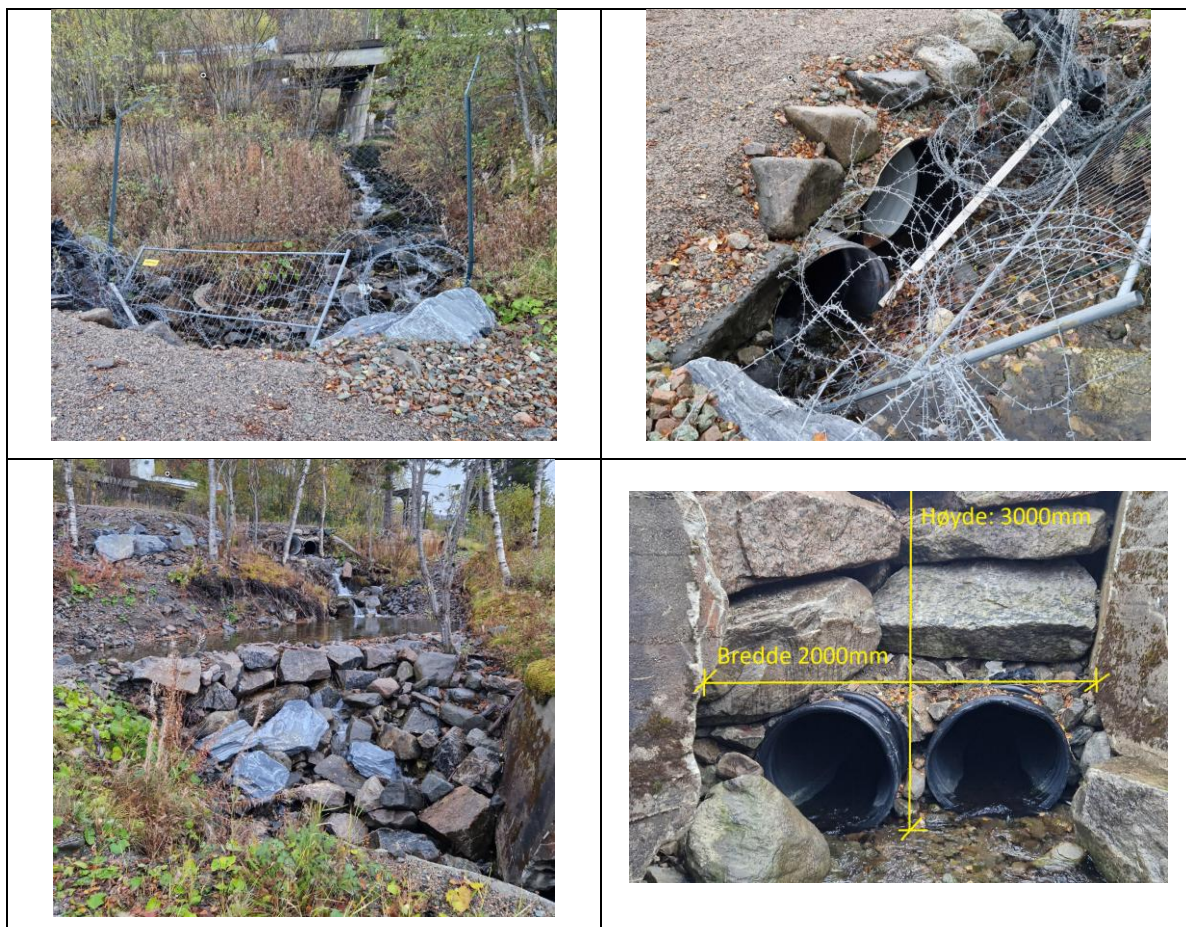
Figur 3-2: Bildet oppe til venstre viser elva mellom bru og kulvert. Bilde oppe til høyre viser innløp til 3 parallelle stikkrenner. Bilde nede til venstre viser et lite oppdemmet magasin mellom utløp kulvert og innløp kulvert. Bilde nede til høyre viser innløp til kulverter mot sjø.
