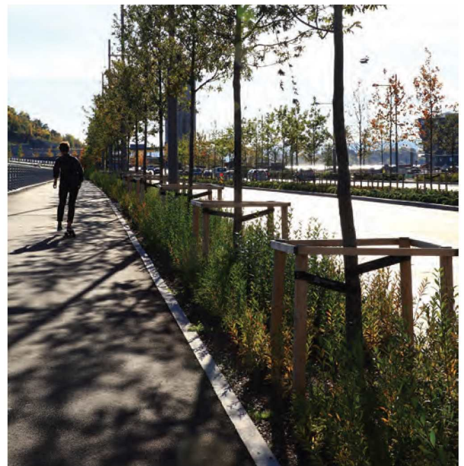
Eksempel på gang- og sykkelveg som er adskilt fra kjørebane med et frodig plantefelt. Kong Håkon 5.s gate i Oslo. Gaten har også nisjer med benker i vegetasjonsfeltet.
