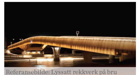
Referansebilde: Lyssatt rekkverk på bru
