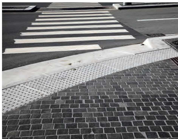
Visuelt og taktilt oppmerksomhetsfelt og nedsenksdetalj i granitt med varselfelt for svaksynte ved fotgjengerfelt i Dronning Eufemias gate, Oslo.
