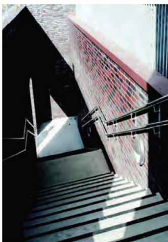
Utetrapp med dobbel håndløper og markering av trinn. Sørenga, Oslo.
