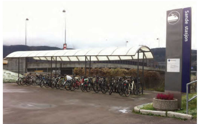
Sykkelparkering under tak. Sande stasjon.
