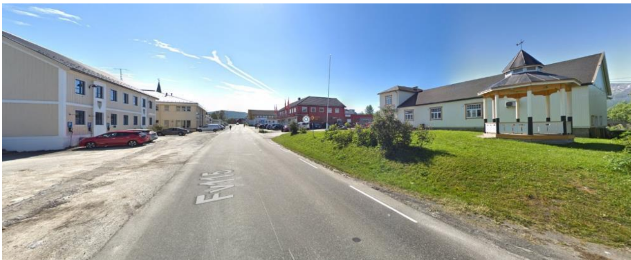
Figur 3-3. Planområdet sett fra nord mot sør. Samfunnshus og torg t.h. Kilde: Google Street View 2018.
