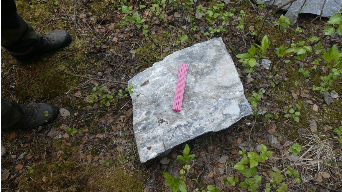
Figur 10: Utrast blokk langs vestre bergskjæring viser antatt typisk blokkform i bergmassen.
