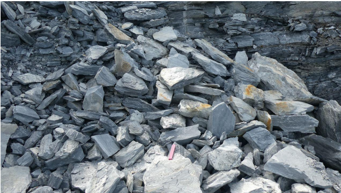
Figur 11: Nylig utsprengte blokker fra østligste del av sørlige bergskjæring. Blokkstørrelsen er her lokalt større enn observerte blokker i resten av skjæring, men med flatere form.
