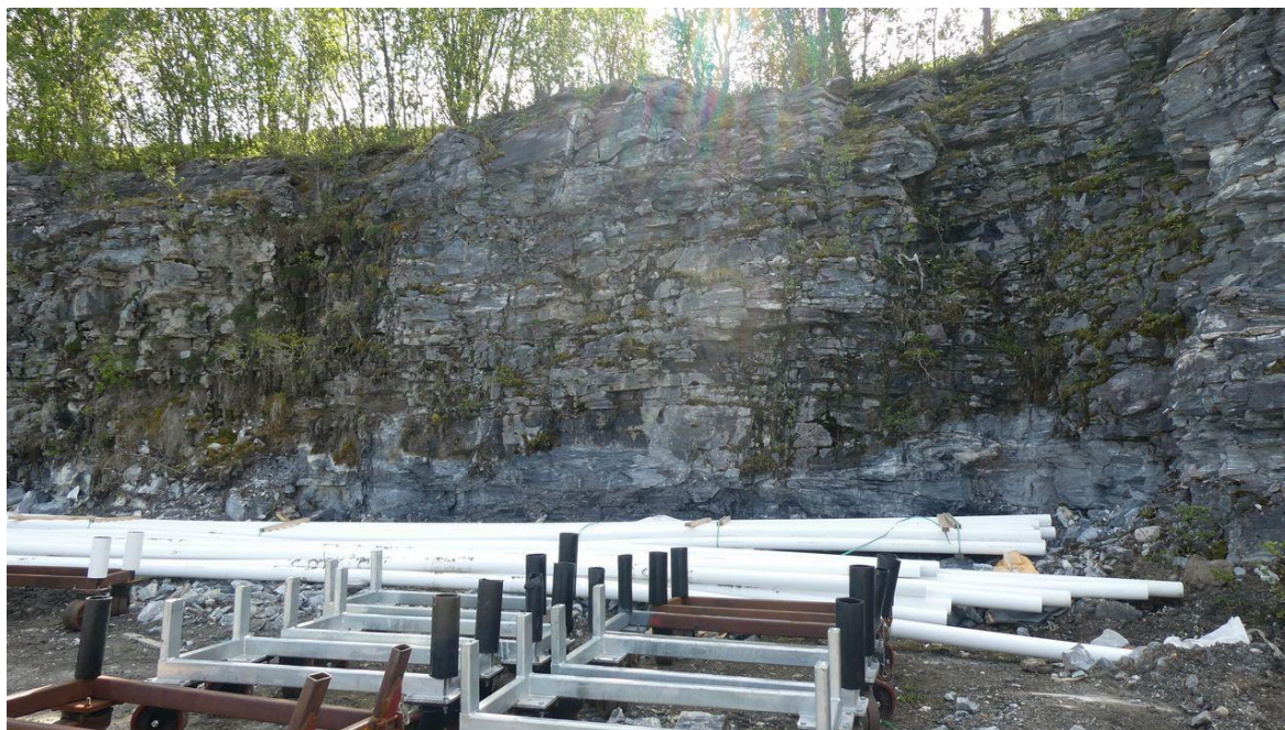
Figur 6: Eksempel på sørlig del av bergskjæring i industriområdet. Bergmassen er her generelt tettere oppsprukket enn i vestlig del av bergskjæring.
